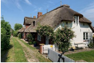
Die Unterkunft verteilt sich über EG und 1.OG.
